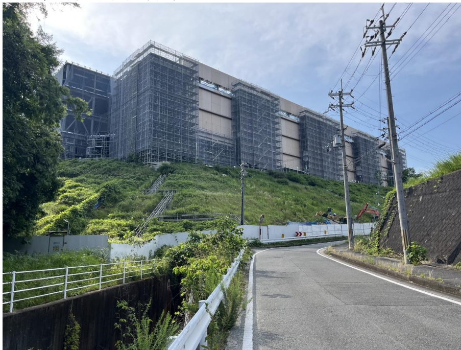
増築工事中の NTT データのデータセンター（精華町光台 2 丁目 4） 2026 年 4 月より運用予定。
