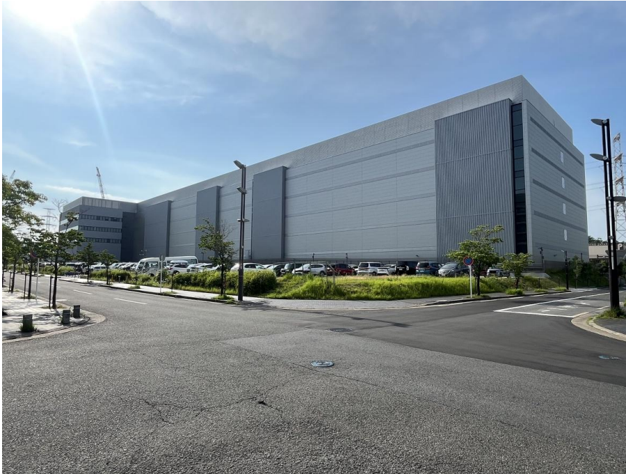
Colt のデータセンター（精華町光台 1 丁目 6-6）
